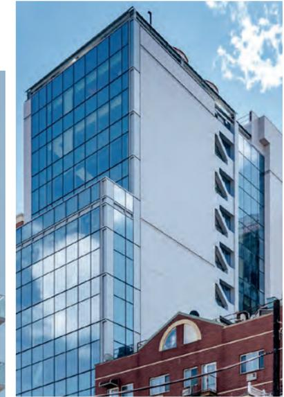
El revestimiento monocromático de la fachada porcelánica ventilada se compone de piezas de gran formato de tres modelos: **Ferroker Níquel**, **Extreme White** de **STON-KER®** y **Deep Light** de **Solidker**. El muro de porcelana **Ferroker Níquel** del lateral resalta sobre el edificio de ladrillo existente.
